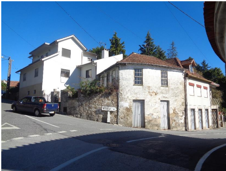
Imagens, 1 - 3. Pormenores fotográficos de arruamentos em Figueiró.
