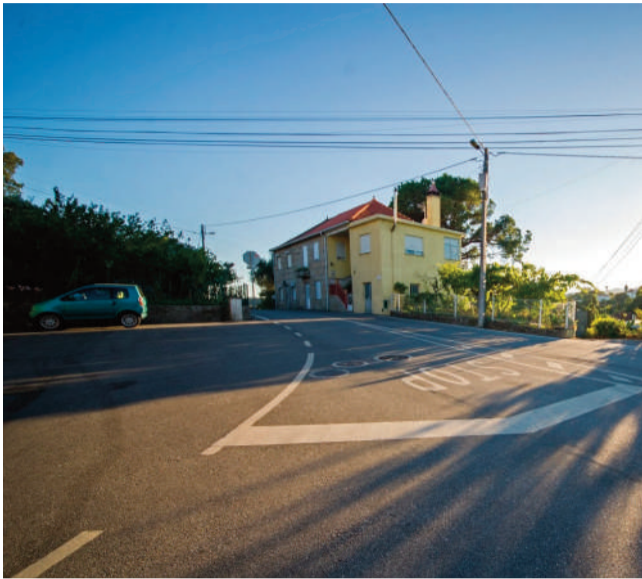
Acessos. A 1ª fase de requalificação da estrada entre a Ponte Seca e Magarelos, em Torredeita, é um dos exemplos da aposta na melhoria das condições viárias na Freguesia.
