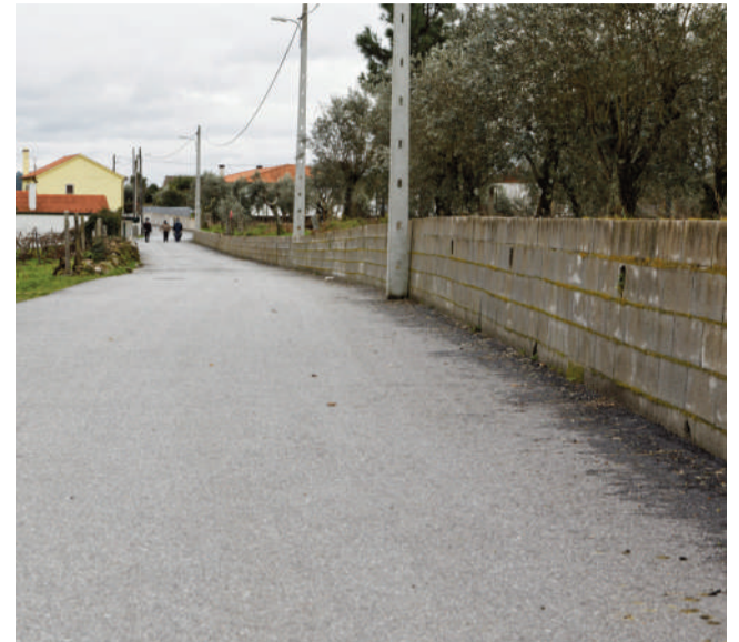
Melhorias. Na Rua da Seixosa, em Boa Aldeia, foram realizadas intervenções ao nível da rede de abastecimento de água e saneamento, assim como a respetiva pavimentação da via. Uma obra que rondou os 67 mil euros.
